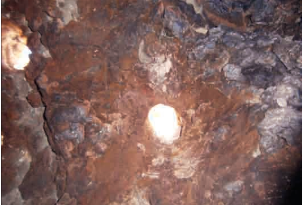
Рис. 6. Вигляд продуху з нижньої топочної камери
