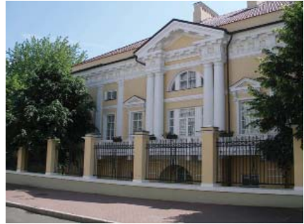
Рис 6. Київ, вул.Покровська 5 кін. XXст.
