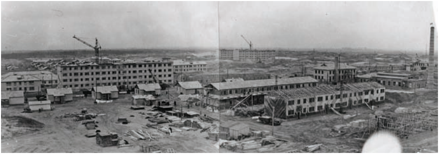
Містечко будується, 1962 р.
