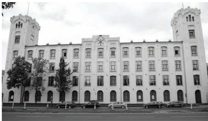
Фото 7. Будівля механічної фабрики бавовняних виробів («белья и трика») Юлія Кіндермана в Лодзі. Побуд. 1897р. Сучасний вигляд.
