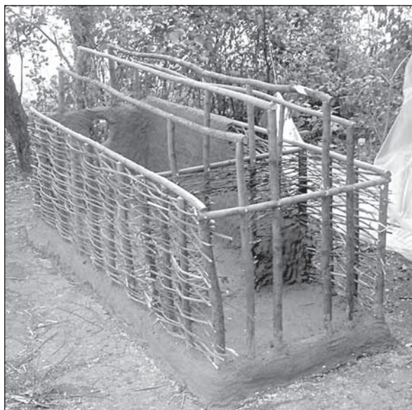
Рис. 1. Процес зведення експериментальної моделі житла трипільської культури
