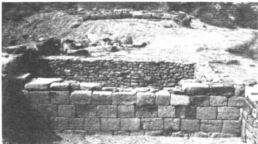
Рис. 3. Будинок Е-5. Підвали V, VI після реставрації
