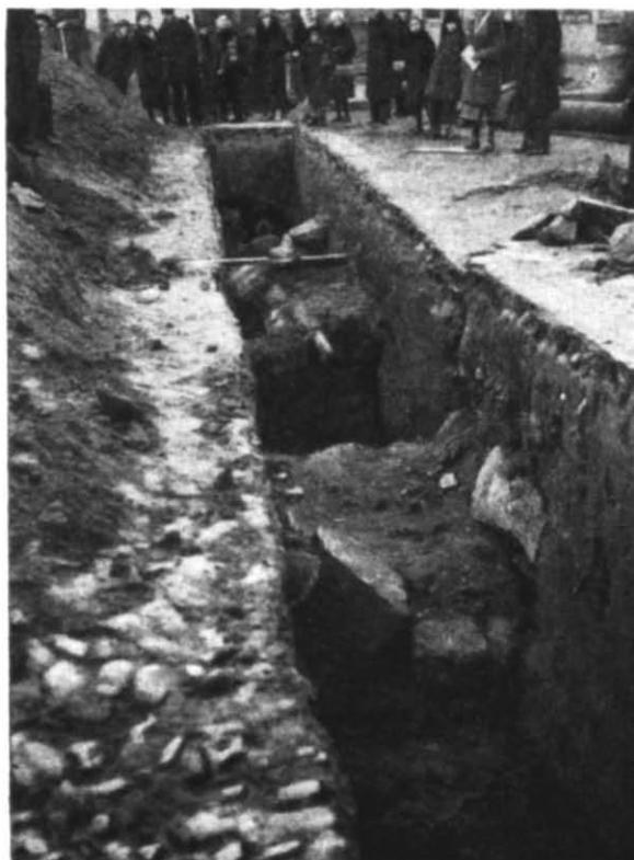
Рис. 3. Фундамент брами, перерізаний теплофікаційною траншеєю у воперечному напрямку (1940 р.).
