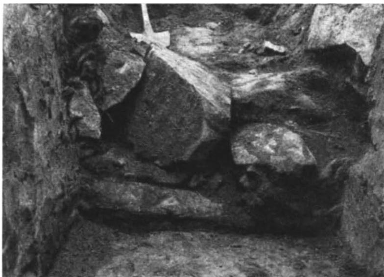
Рис. 4. Бутова кладка східної частини фундаменту брами у теплофікаційній транші 1940 р.
